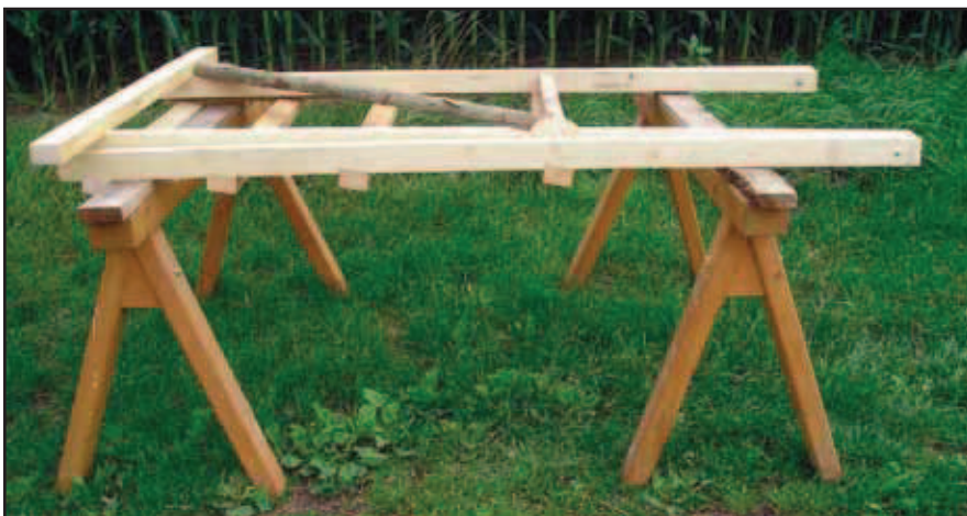
Die Einzelelemente werden auf Zimmermannsschragen zusammengebaut (Fotos und Abb. © H. Raßhofer)
